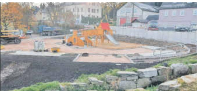
Die Modellierung der Platzfläche ist nahezu abgeschlossen. Auch das neue Spielgeräte wurde errichtet. Als nächste Schritte sind die Begrünung, die Errichtung der neuen Beleuchtung sowie das Aufstellen der Bänke und Schutzhütten geplant.
